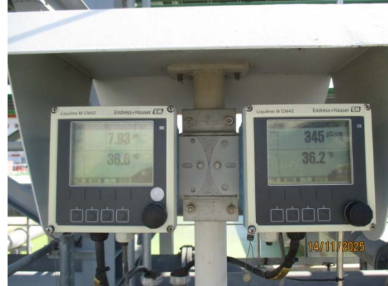
W2 : ระบบติดตามตรวจสอบคุณภาพน้ำทิ้งแบบต่อเนื่อง (Online Monitoring) ของบ่อกักน้ำทิ้ง (Retention Pit)
