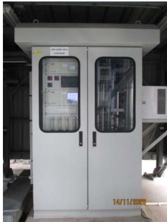
เครื่องตรวจวัดคุณภาพอากาศจากปล่องอย่างต่อเนื่อง (CEMS) ของปล่อง HRSG 21
