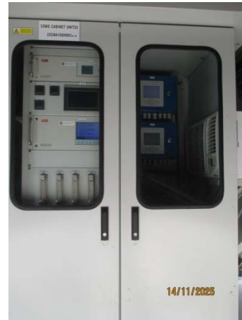
เครื่องตรวจวัดคุณภาพอากาศจากปล่องอย่างต่อเนื่อง (CEMS) ของปล่อง HRSG 22
